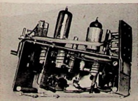
Bild 11. Der geöffnete UKW-Baustein von Loewe-Opta mit Dreifach-L-Abstimmung
